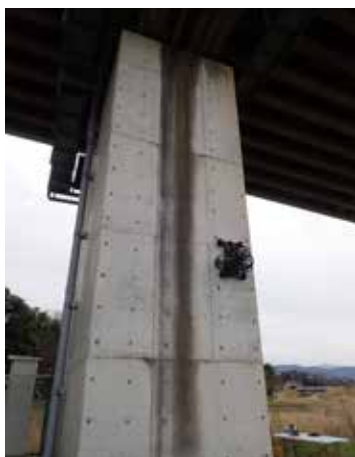
富山市が管理する橋脚をよじ登りながら点検をするロボット ((有) ボーダック/日東建設(株)との共同研究)
